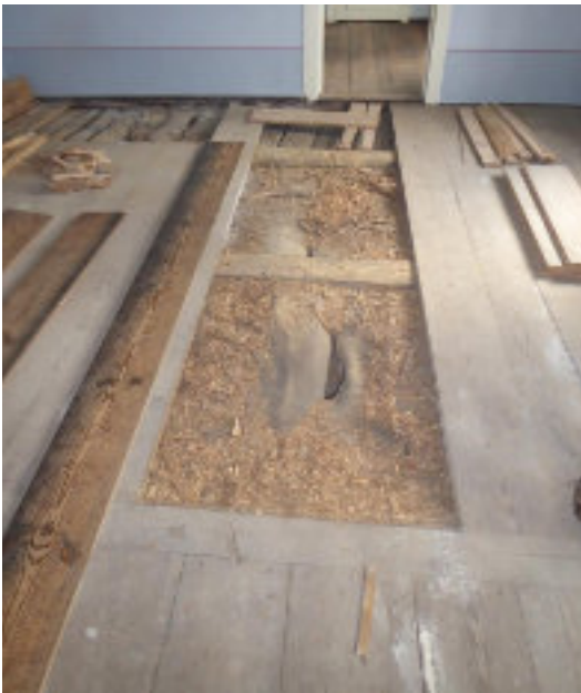
Reparatur der alten Dielung
